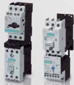
Salidas a motor equipadas sin y con fusibles
